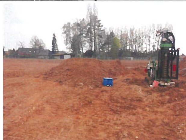
MOY 5-1 : Emplacement supposé d'une ancienne chaudière de fioul lourd avec cuve
