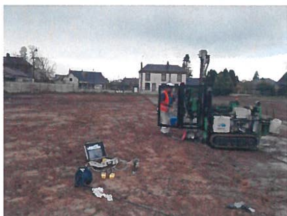
MOY 1-1 GS : Cuve enterrée de gazole dans l'usine
