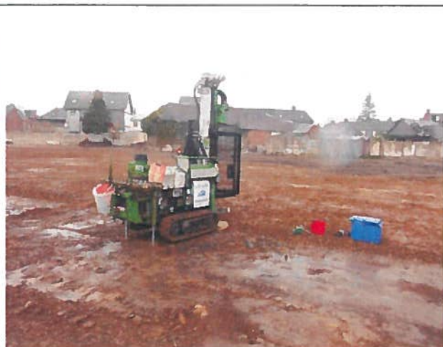
MOY 1-1 : Cuve enterrée de gazole dans l'usine
