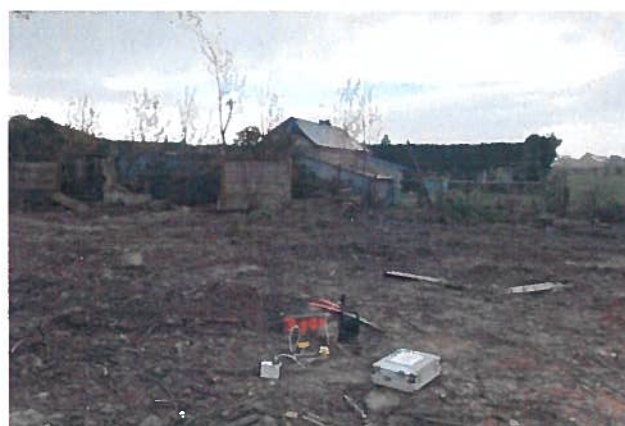
MOY 3-1 GS2 : ex cuves aériennes de fioul domestique et de gazole
