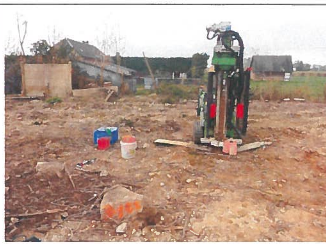
MOY 3-1 : 2 ex cuves aériennes de fioul domestique et de gazole
